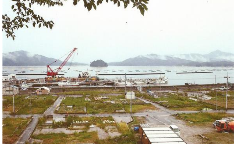
Préfecture de Sendai : reste des fondations des habitations
